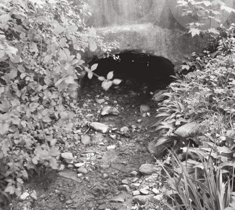
Dorfbach Durchlass vor der Erneuerung
