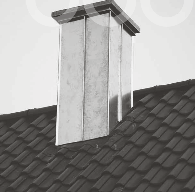
Kaminverkleidungen – eine der Spezialitäten der Spenglerei Kaufmann.
