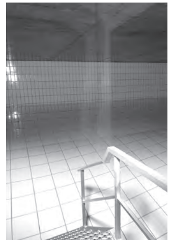
Wasserbecken im Reservoir
