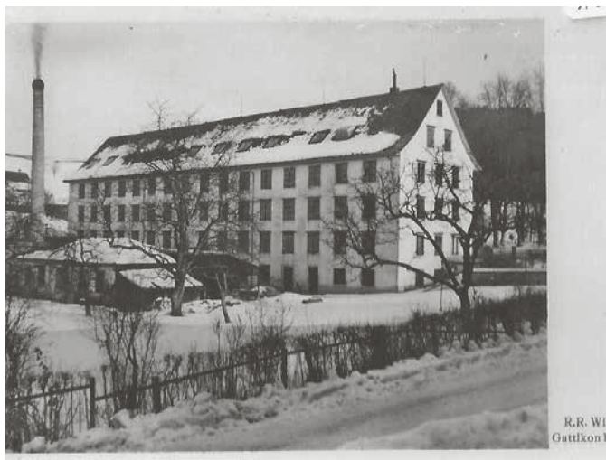
Fabrikgebäude von Heinrich Schmid in Gattikon
