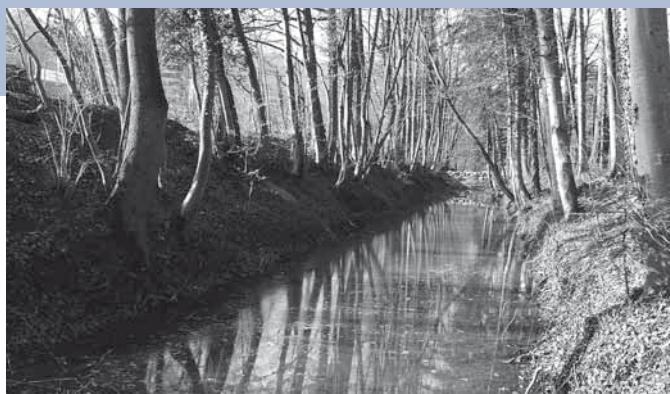
Das neu angelegte Dammprojekt im alten Spinnereikanal
