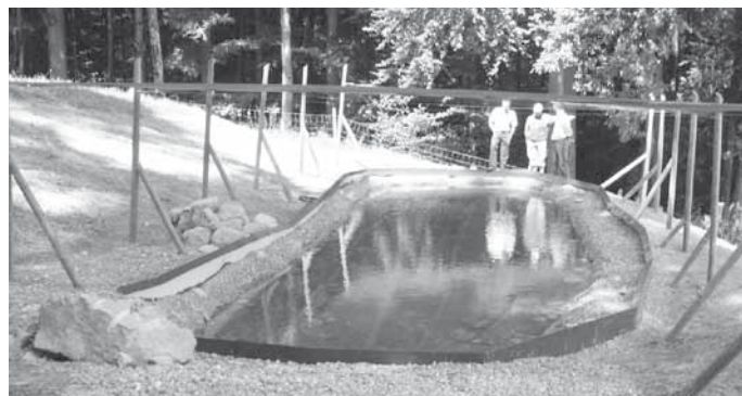
Die Steinkrebszucht auf der Rinderweid kurz vor der Fertigstellung
