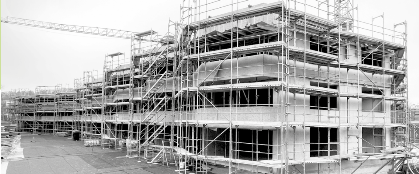
Der Bau ist schon fortgeschritten. Wohnen im Alter im Langmoos.
