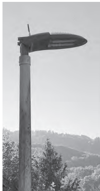
60% der Langnauer Strassenbeleuchtung sind bereits auf LED umgerüstet
