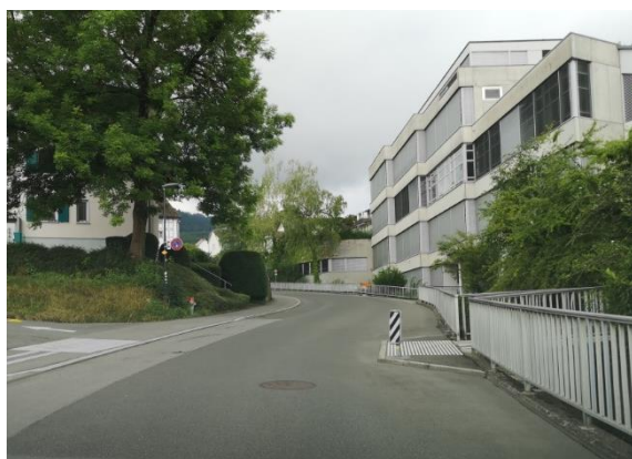
Abbildung 5: Seitliche Einengung Alte Dorfstrasse
