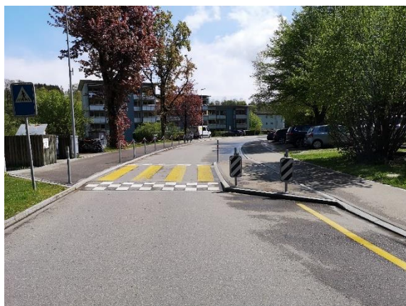
Abbildung 8: Vertikalversatz Breitwiesstrasse 18
