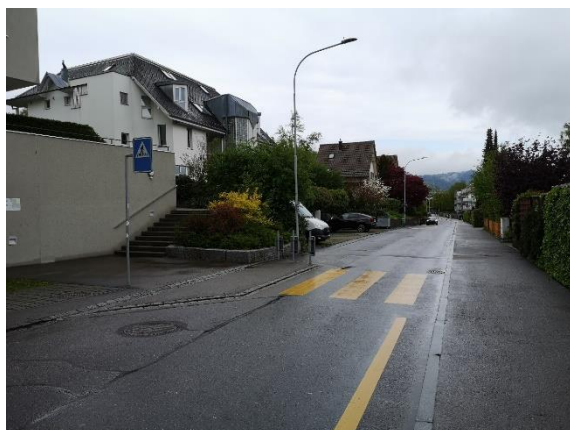
Abbildung 7: Trottoirnasen beim Fussgängerstreifen Höflistrasse 10
