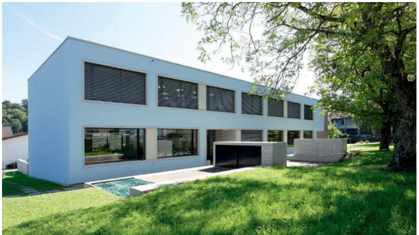
Südwest Fassade IST-Zustand
