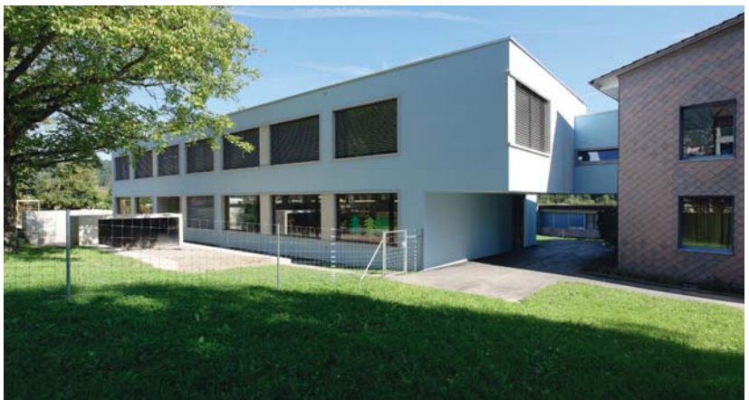
Südwest Fassade IST-Zustand
